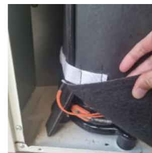
Нагреватель масла картера компрессора (в наружных блоках 48/60 кВт/ч)
