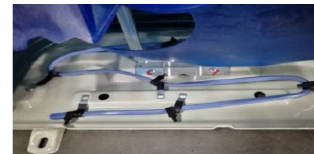
Нагревательный элемент основания корпуса (в наружных блоках 48/60 кВт/ч)
